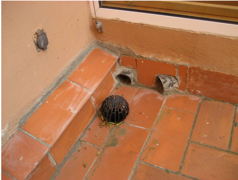
Foto 4.- Detalle sumidero y salida tubos bajo pérgola.
