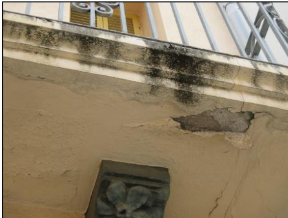
Fotos 31 y 32.- Detalle afectación en parte baja balcón y zócalo de piedra natural
