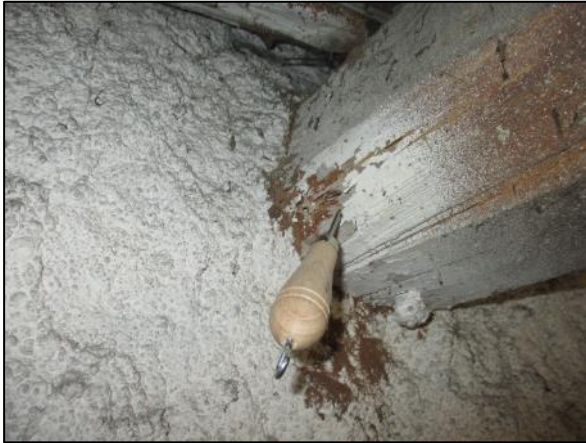
Fotos 25 y 26.- Afectaciones en cabeza de vigas y en zona central
