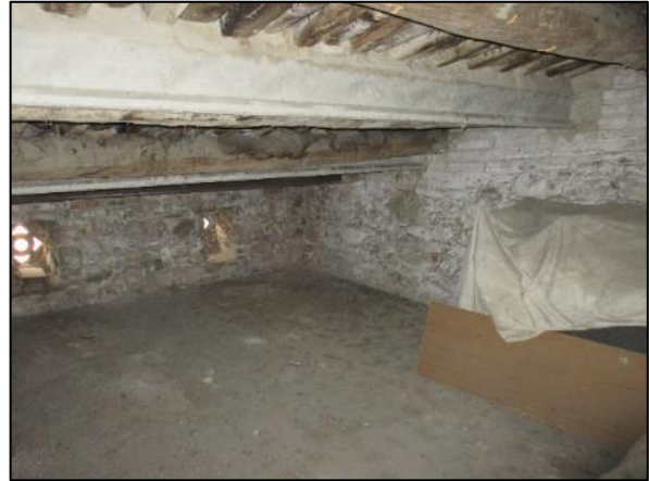
Foto 16.- Bajo-cubierta junto a fachada principal
