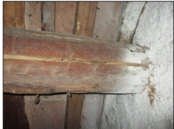
Fotos 27 y 28.- Agrietamiento y pérdida de masa en vigas de madera
