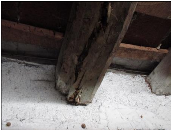
Fotos 27 y 28.- Agrietamiento y pérdida de masa en vigas de madera
