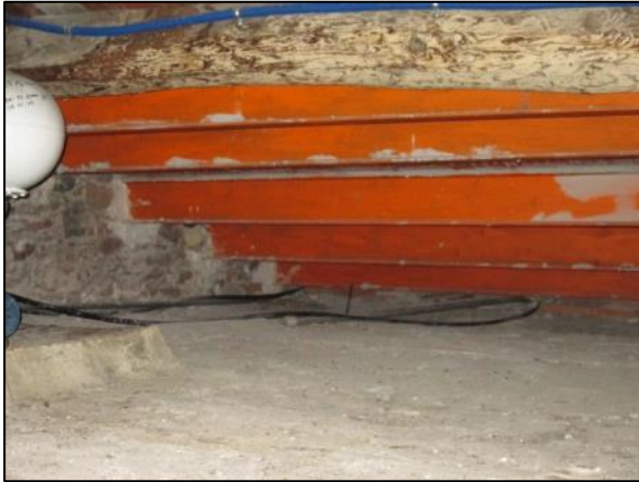
Foto 15.- Vigas de refuerzo en cubierta zona post.
