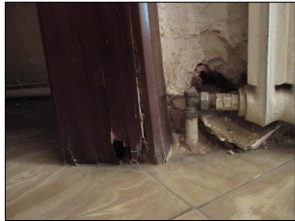
Foto 4.- Marco paso pasillo-escalera
