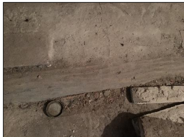
Foto 11.- Viga techo P1 vista desde bajo-cubierta
