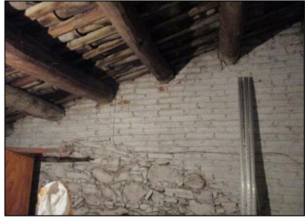
Fotos 17 y 18.- Refuerzo vigas zona anterior edificio principal y vista general medianera izquierda
