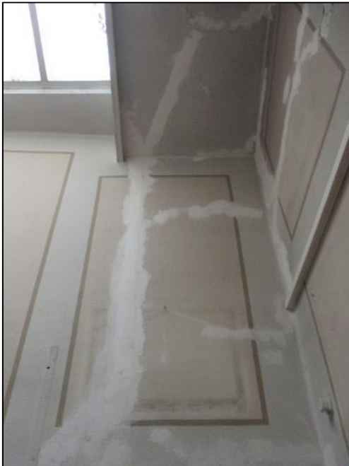
Foto 7.- Parte superior caja escalera
