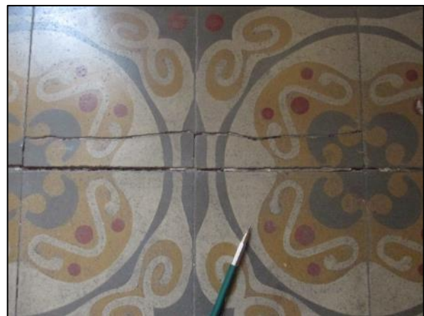
Fotos 21 y 22.- Vista general y detalle de junta entre piezas abierta y fisura en pavimento P1.
