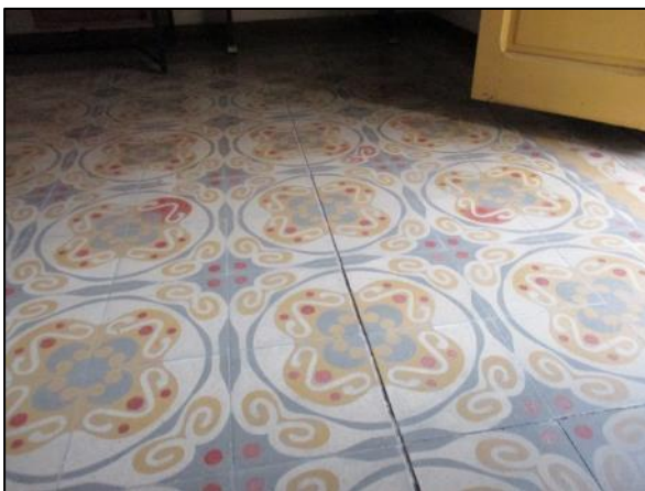
Fotos 21 y 22.- Vista general y detalle de junta entre piezas abierta y fisura en pavimento P1.
