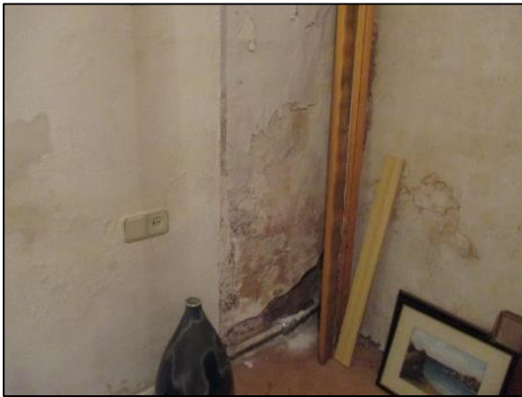
Foto 3.- Medianera izq. Habitación
