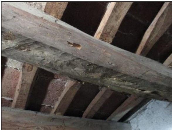
Foto 19.- Vista estructura techo PB cuerpo posterior
