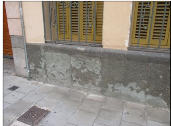
Fotos 31 y 32.- Detalle afectación en parte baja balcón y zócalo de piedra natural
