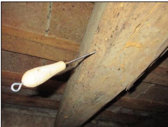
Foto 29.- Afectación generalizada por insectos
