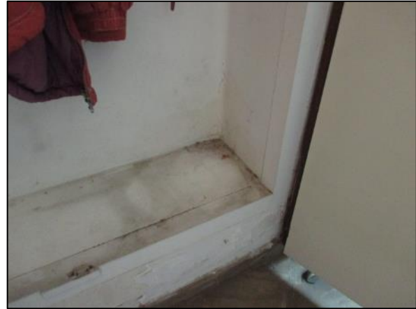
Foto 2.- Medianera der. Junto acceso
