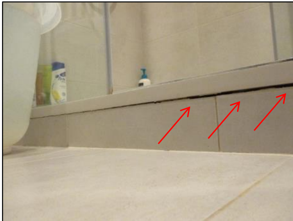
Foto 9 y 10.- Fisuración en piso 2º2º.
