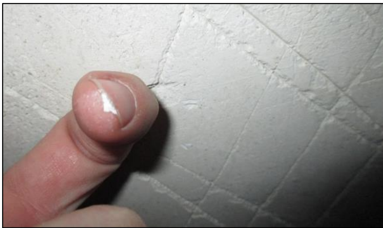
Foto 8.- Yeso detectado al rascar la pared con la uña.
