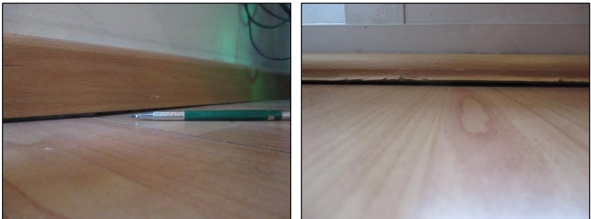
Foto 13 y 14.- Encuentro parquet con fachada galería posterior.
