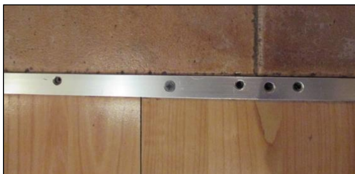
Foto 17.- Regleta de transición entre pavimentos.
