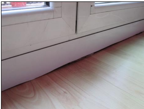
Foto 15.- Encuentro de parquet con carpintería fachada principal.
